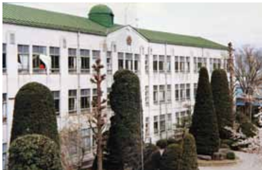
一棟 改築前 の校舎
