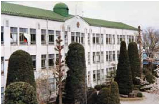
一棟改築前の校舎
