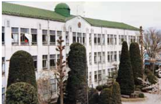
一棟 改築前の校舎
