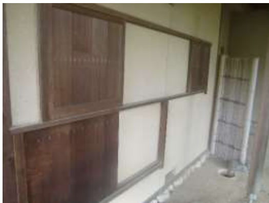
④ 木枠の防腐剤処理
