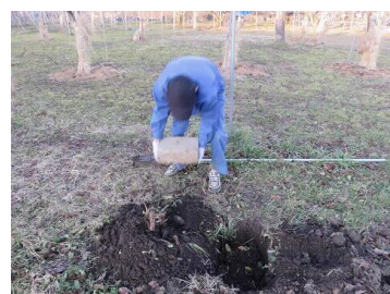
図7 掘り出した受石の設置
