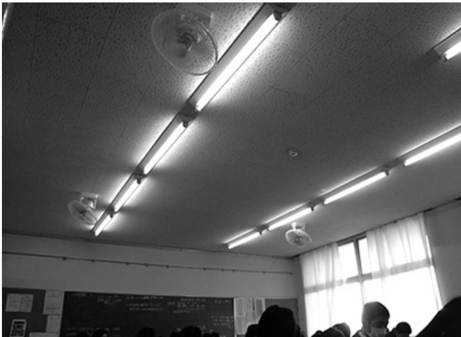
各HR教室に設置された扇風機
