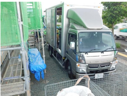
発泡スチロールの断熱材を吹き付ける車
