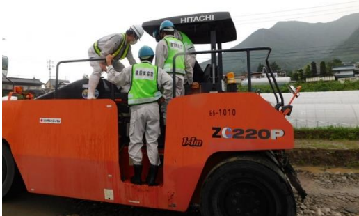
路面を転圧する重機
