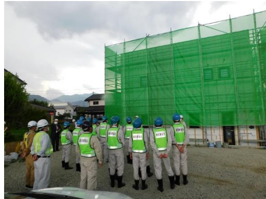
中野市内の建築現場
