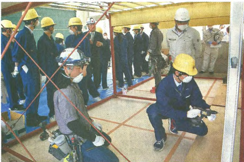
長室協の協力で内装工事を体験
