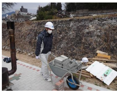
インターロッキング ブロック の搬入
