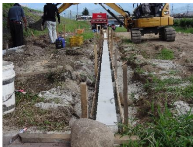
丁張に従って縁石を施工
