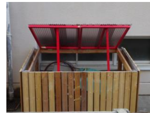
回収BOX側壁・ふた製作
