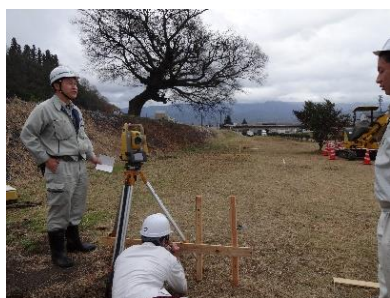
測量して丁張（ちょうはり）掛け
