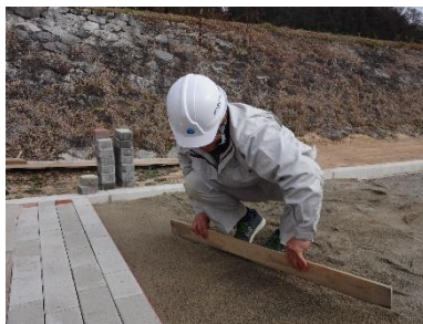
路盤に砂を入れて水平に均す
