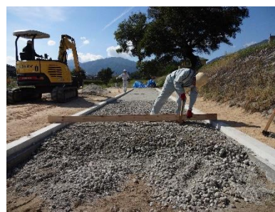
舗装路面の下地を施工
