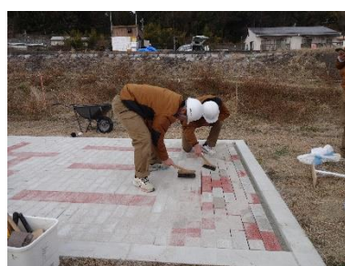
すき間（目地）を等間隔に
