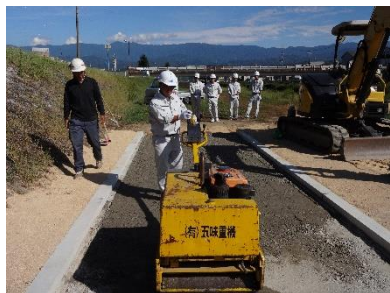
ローラーで転圧して締め固め
