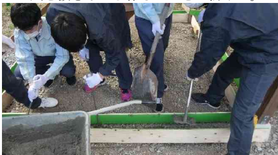
図4 コンクリートを流し込む様子
