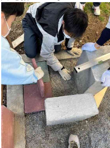
図5 タイルを敷き詰める様子
