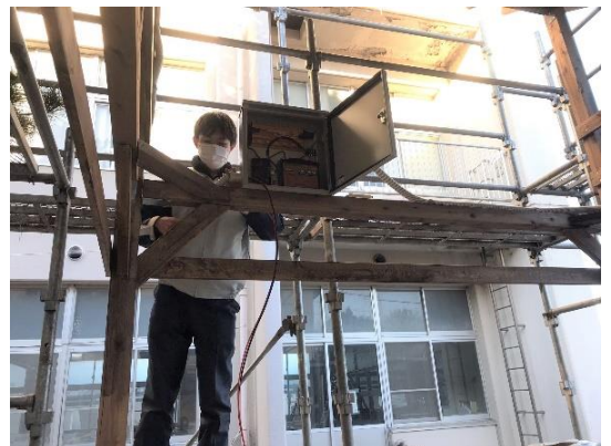
図 2 6 配線を行っている様子
