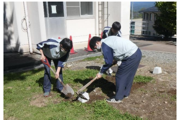
図17 沓石を埋めている様子
