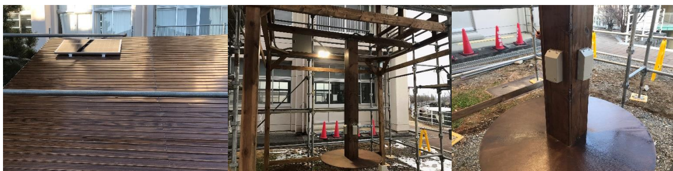
写真3 ソーラーパネル・LEDライト・コンセントを設置した
