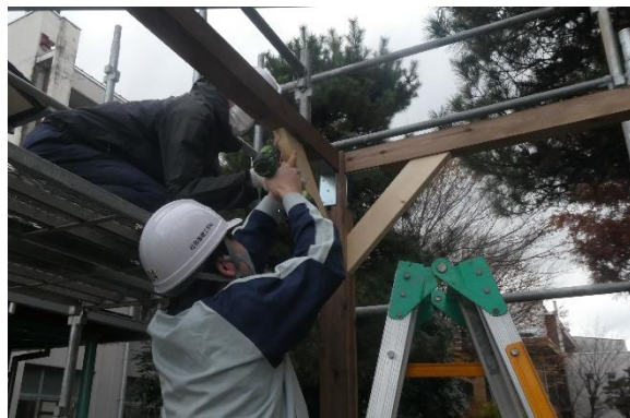
図20 補強している様子
