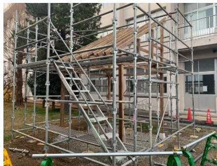
写真2 柱の組立て完了後
