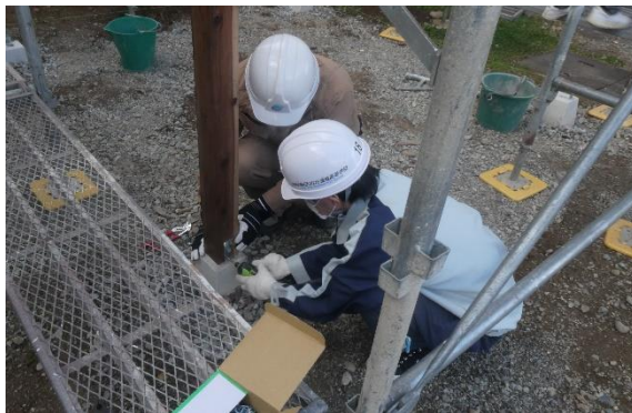
図19 柱を固定している様子
