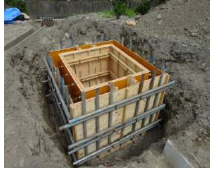
沈砂槽型枠設置
