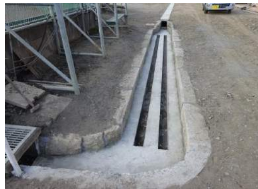
上流部の完成
