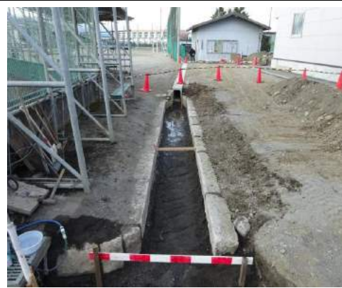
御影石設置完了
