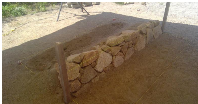
重厚感ある石積み完成
