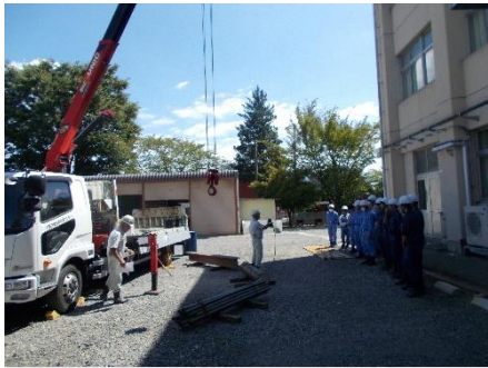
緊張するクレーンの操作
