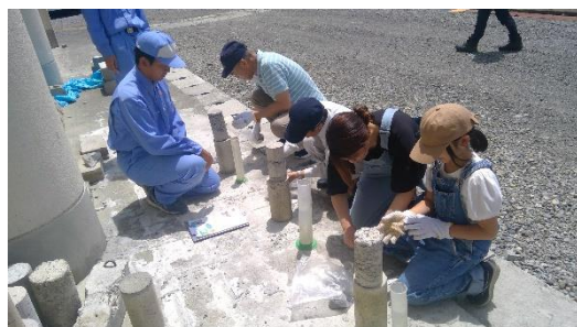
モルタルを作って補修の練習
