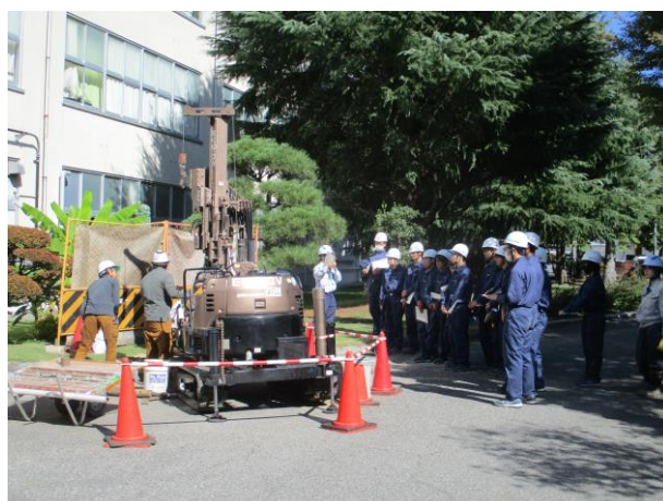
掘削の様子②
