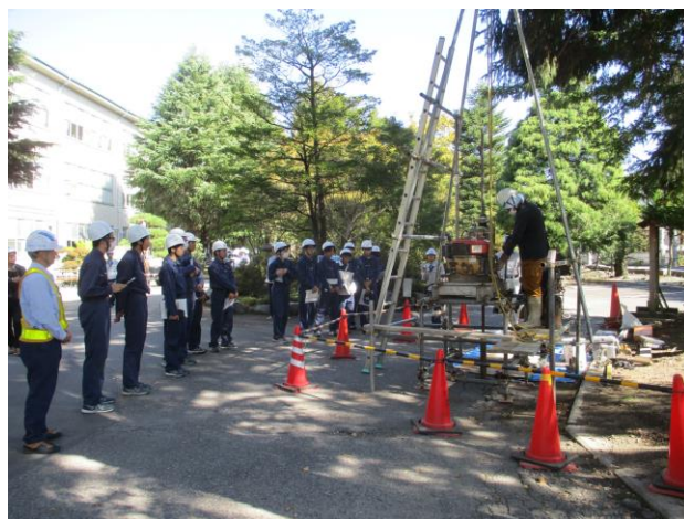
掘削の様子①
