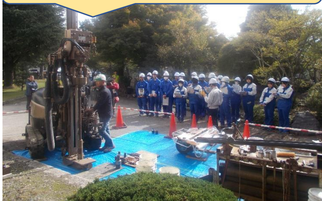
② ボーリング調査の様子
