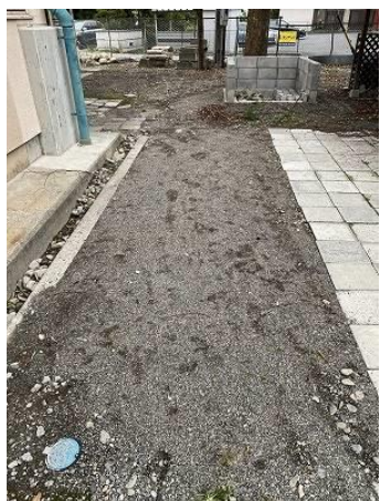
施工前の様子
