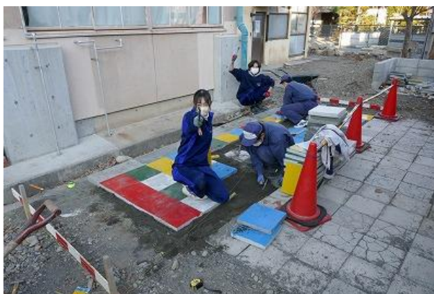
作った平板を設置しています
