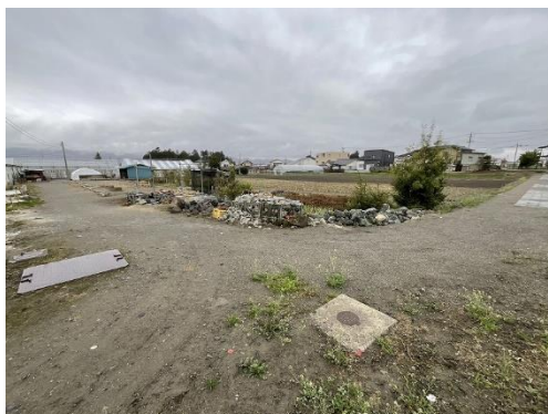
ここに歩道平板舗装を行います
