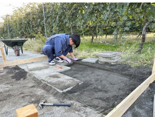
丁張りに合わせて 平板を設置しています
