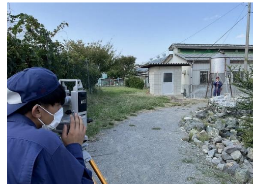
測量して杭を設置しています
