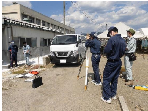
測量会社の方々にご協力いただき 現場の測量を行いました
