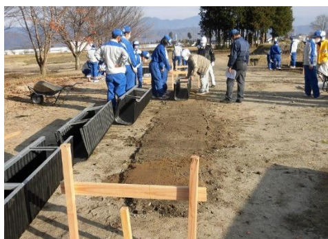
水平を確認しながらU字溝を据え付けます
