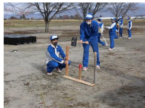
予定の場所に杭を打ちます
