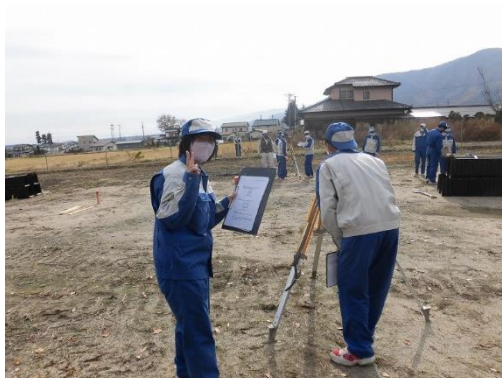
現場を測量します
