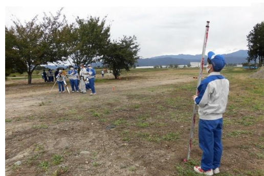
測点の高さも測量します
