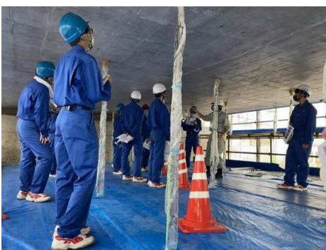
橋梁の下を補修していました
