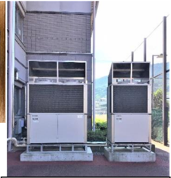
(左) 1年教室用室外機 (右) 会議室等室外機 (左上) 故障した基盤
