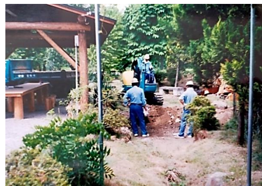
池の外構工事
