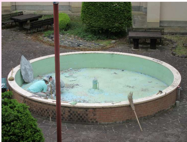
工事開始の様子(先月23日)
