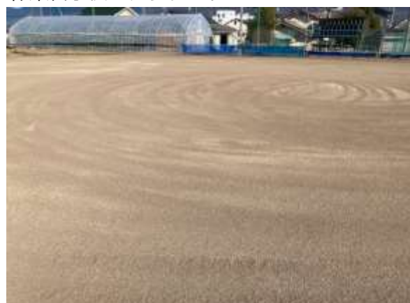
作業終了後のグラウンド
