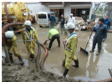
▲冠水した正門南側の道路で排水作業と泥の撤去作業を手伝う本校職員
