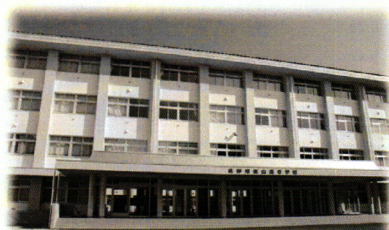
平成25年9月 新校舎完成 平成25年10月 新校舎引越
