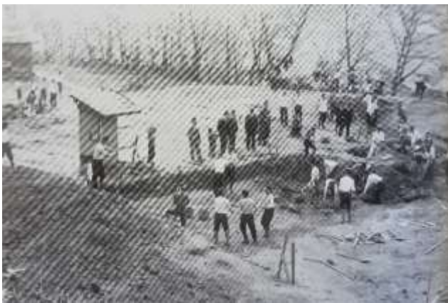
城山にプールを造成
