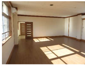
【改修工事後の合宿所の様子】
