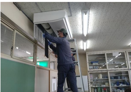
エアコンフィルターを外して掃除
