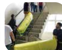
資材の運び込み
