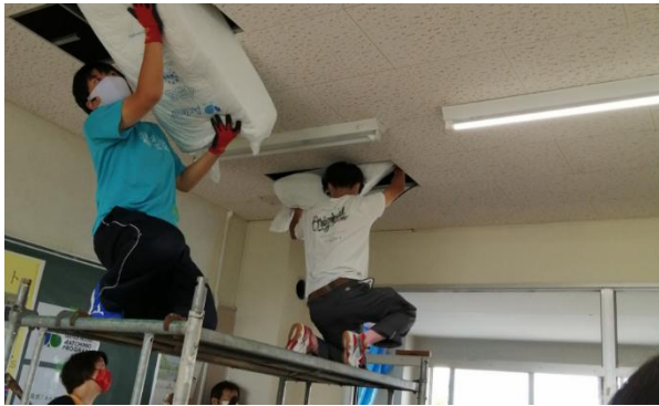
イ 天井裏に断熱材（「アクリア」厚さ 200mm）を設置していく作業
