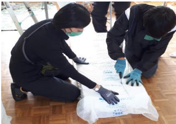
ウ 天井裏に設置する断熱材をカットしていく作業
