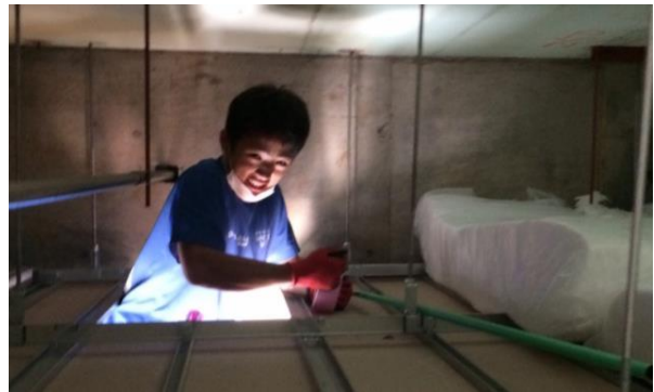
イ 天井裏に断熱材（「アクリア」厚さ 200mm）を設置していく作業
