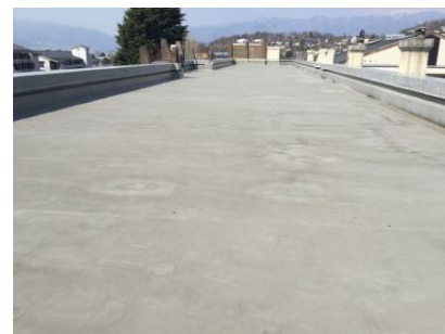
1棟屋上には2mごとにテープが
