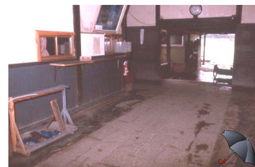
玄関・事務室
