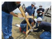
6班に分かれて、測量機器や道具を使い、午前中の計算を基に丁 張をグランドに設置しました。杭を打ち込んでいる時に曲がってし まったり、釘がうまく打てなかったり、方法を教えていただきなが ら正確に設置していきました。
