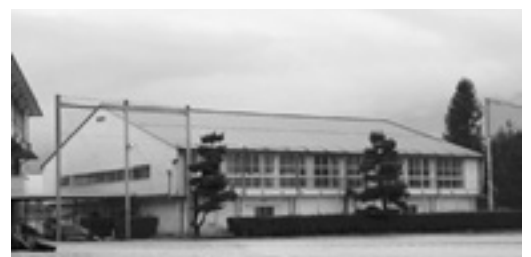
建て替えられる第一体育館
