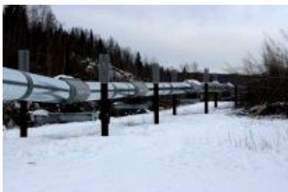
永久凍土トンネルでの研修のあと、近くを通っているトランス-アラスカ・パイプラインシステム (Trans-Alaska Pipeline System)を見学しました。このパイプラインは北部の油田地帯プルドーベイと南部の港バルディーズを結ぶ1300kmに及ぶ施設で、万里の長城に並ぶ人類が作った長大な構造物とのこと。永久凍土を溶かさないうちに地上に設置したり、アラスカの大型動物の移動を妨げない工夫もされているとのこと。使われているパイプは、建設当時日本以外の技術で製造が不可能であったため、すべて日本製(新日鐵製)であるとのこと。
