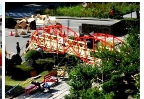
社会基盤工学科の橋はレンズトラスト橋といえます。実在する珍しい構造の橋をモデルにしています。
