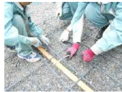
鉄筋コンクリート作成
