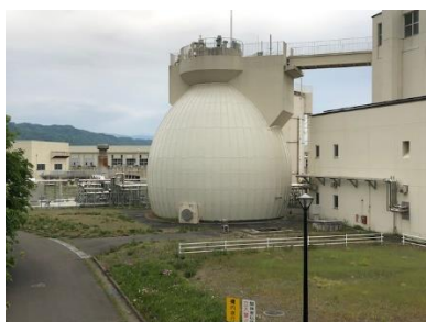
第13図 アクアピア安曇野の消化タンク
