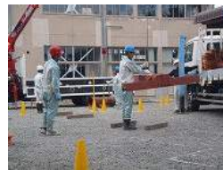
小型クレーン実習
