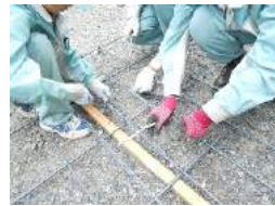
鉄筋コンクリート作成
