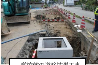
学校前の道路拡張工事
