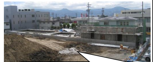
プール8月27日現在：プールと建屋のコンクリート打設が終了しました。
