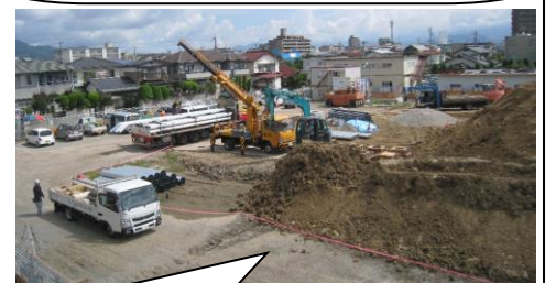
校庭は盛土され、防球ネット設置中
