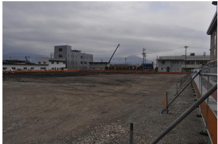
H27.4.17 現在 北側道路から見た風景 寄宿舍、食堂がきれいに解体されました
