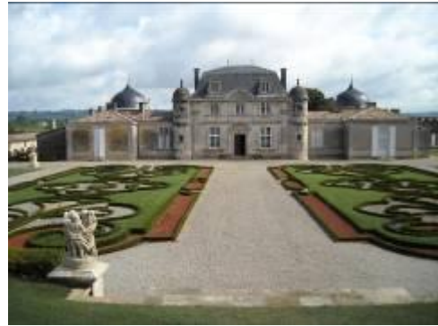
(図8 ドウ・マール建物)
