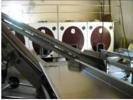
(図7 コンクリート製の発酵槽)
