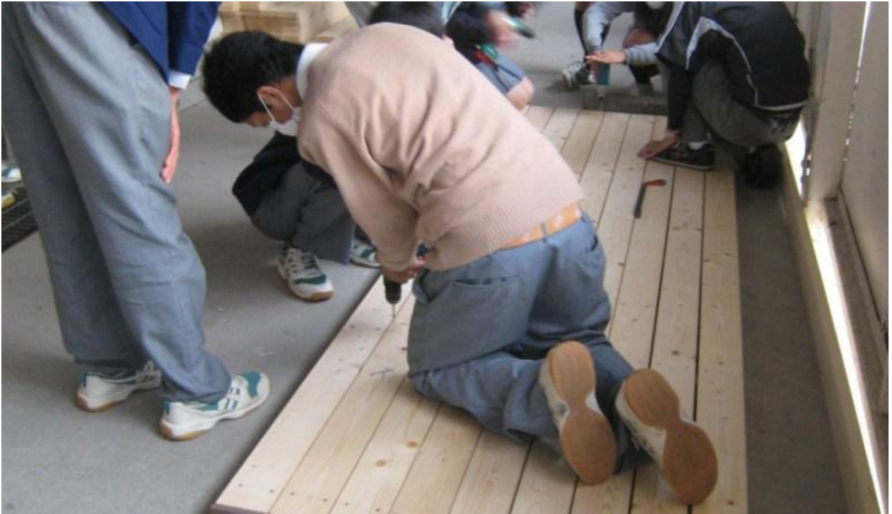
スノコ板を釘で固定中
