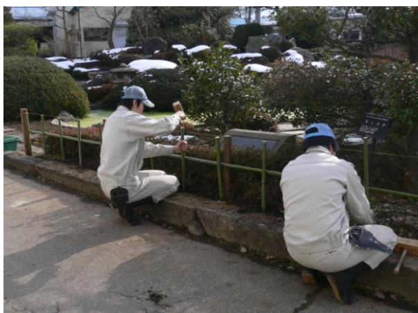
生徒の施工風景
