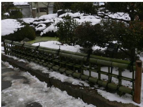
施工後の様子
